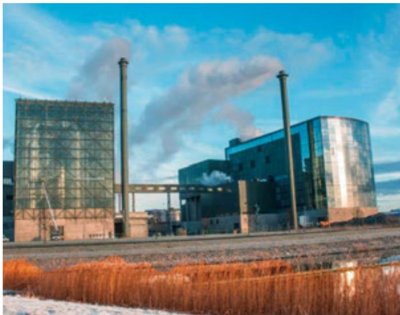
La planta alimentada por residuos de Linköping, en Suecia, que genera electricidad y calienta agua para uso doméstico y comercial, aprovecha el 90 por ciento de la energía total. Este sistema centralizado de «calefacción urbana» calienta muchos edificios en Suecia.
